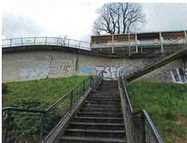
Escalier en porte-à-faux remplacé par un nouvel élément en construction métallique
