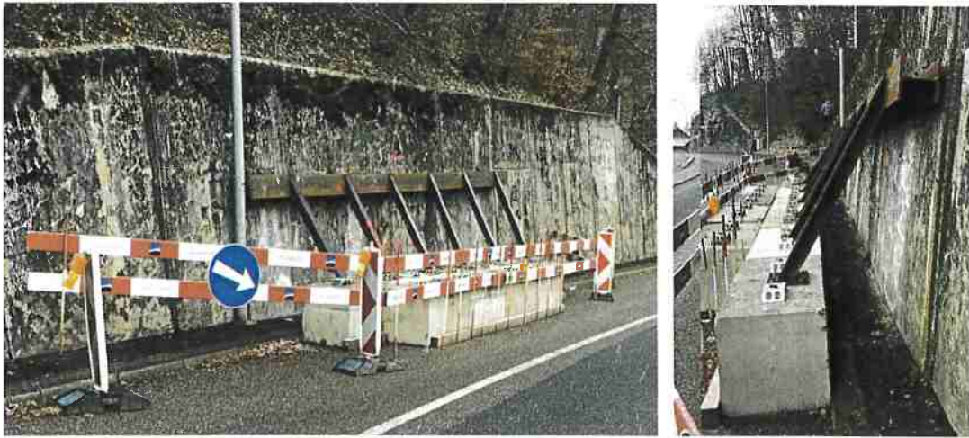
Sécurisation et étayage d'urgence réalisé fin 2023
