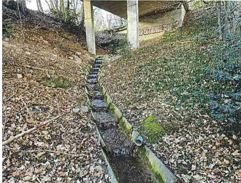
Photo de l'extrémité amont, sous le pont de la route de Nant (photo bureau Gemetris SA)
