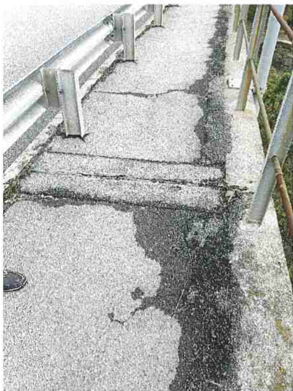
Etat existant du revêtement de surface et des joints de dilatation
