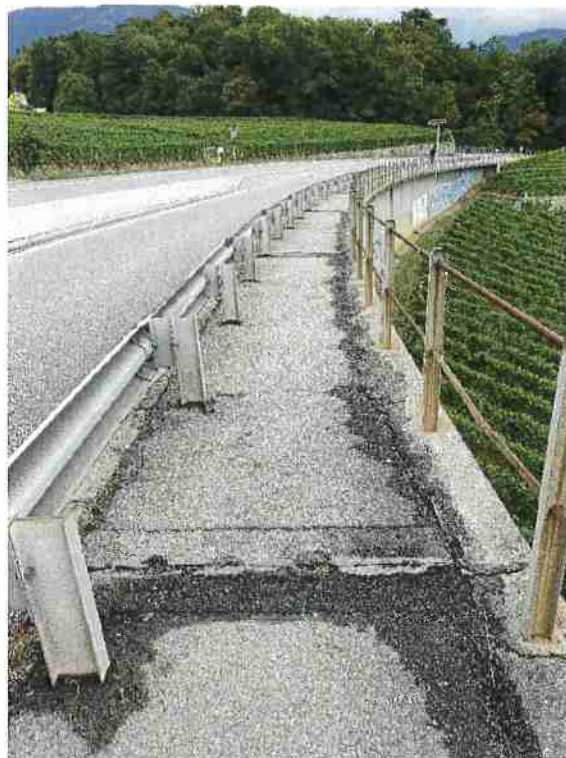
Etat existant du revêtement de surface et des joints de dilatation
