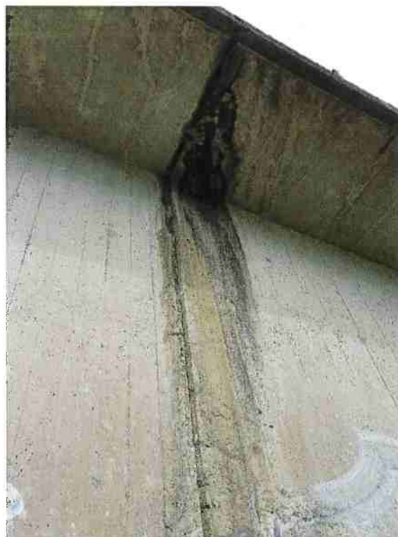
Etat existant de la sous-face du trottoir et du mur de soutènement
