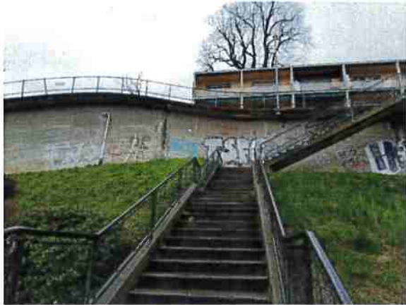
Escalier en porte-à-faux remplacé par un nouvel élément en béton armé
