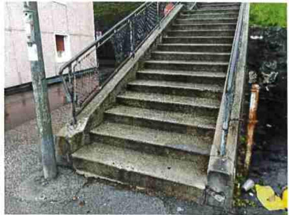
Départ de l'escalier depuis le chemin Vert
